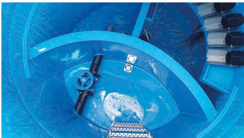
Quellsammelschacht mit Einstiegsleiter und Quellzuleitungen, Seiher und Absperrventil
