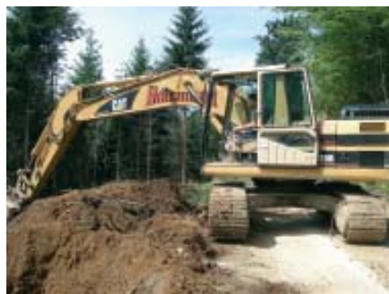
Rohtrasse bereits fertig gestellt
