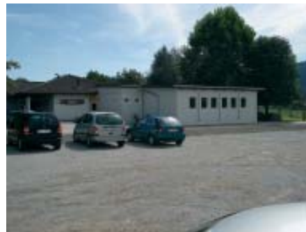
Container-Zubau Kindergarten Waldhausen
