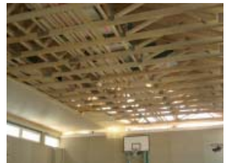
HS-Turnsaal: Deckenbefestigung in Arbeit
